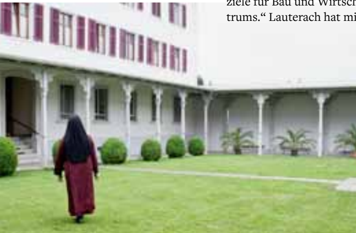
Sanierung St. Josefskloster Wolfgang Ritsch Baujahr 2004
