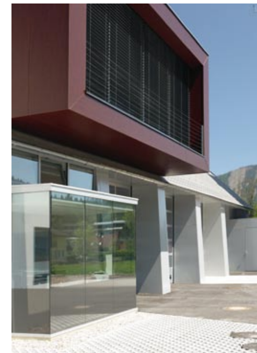
Feuerwehrzentrum Planung Robert Oberbichler Baujahr 2009
